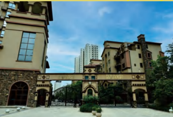
空气源热泵项目案例：天诚·蔷薇公馆
