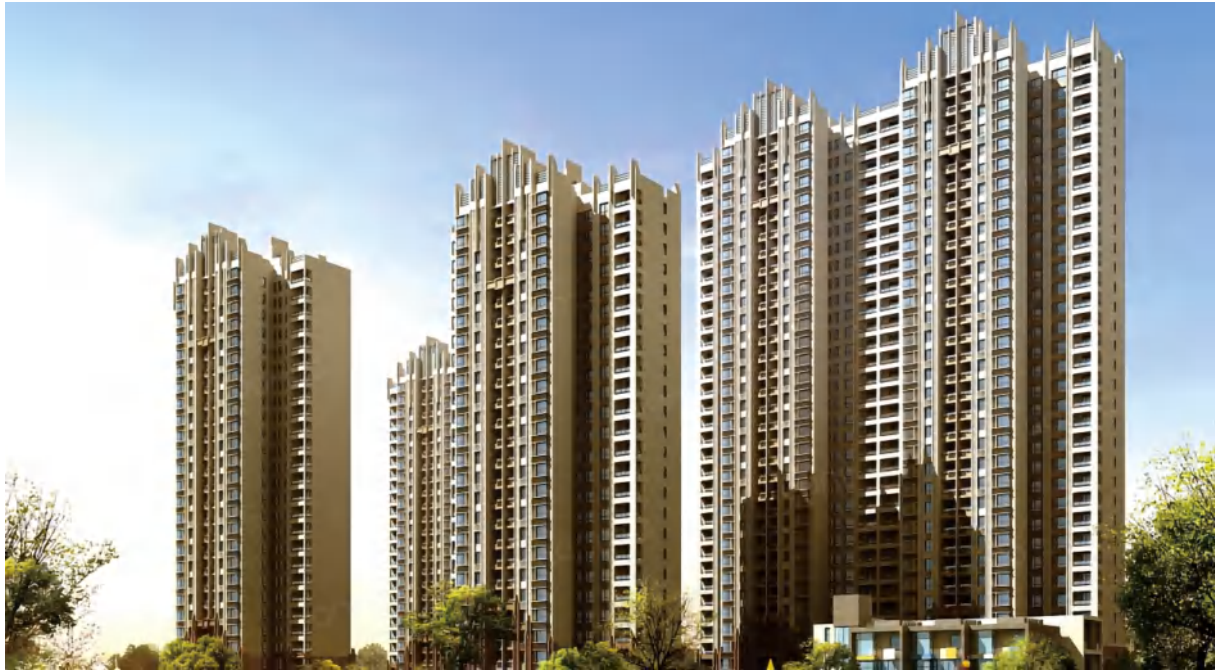
科达·东御兰汀(一期、二期) (浅层土壤源+中深层无干扰地热能) (EC模式) 项目地址:西安浐灞生态区 供热(冷)面积:38.00万m 2 投入使用时间:2016年11月(一期)、2018年11月(二期)
