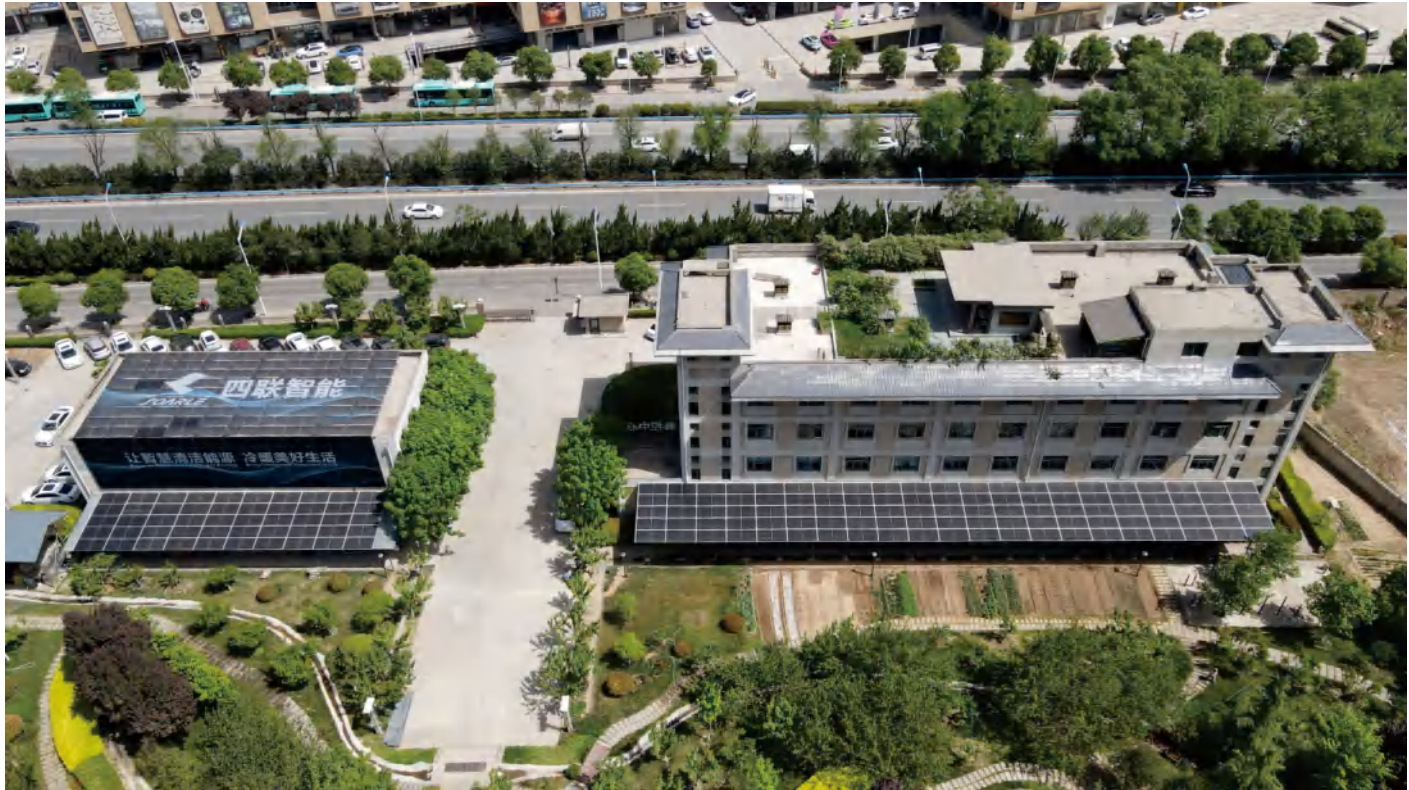
四联绿色能源中心分布式光伏电站项目——陕西首个全彩光伏电站项目, 地热+综合能源示范项目。
