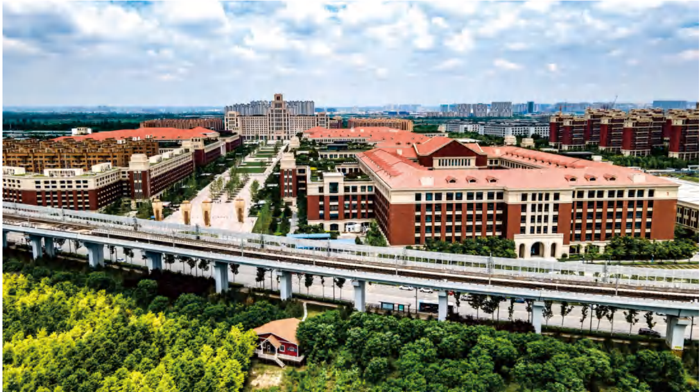
中国西部科技创新港(EC模式) 项目地址:西安 西咸新区 沣西新城 供热(冷及生活热水)面积:159.00万㎡
