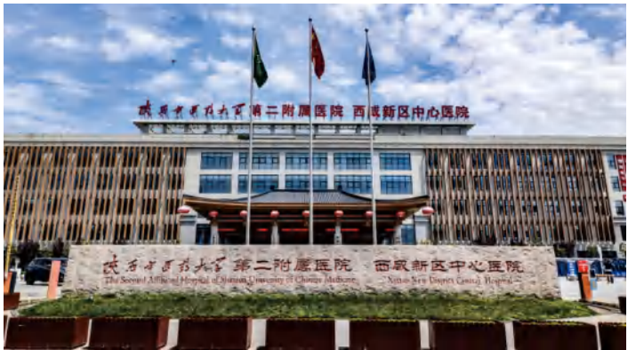
陕西中医药大学 第二附属医院 西咸新区中心医院(EC模式) 项目地址:西安 西咸新区 沣西新城 供热(冷、生活热水及蒸汽)面积:15.78万㎡
