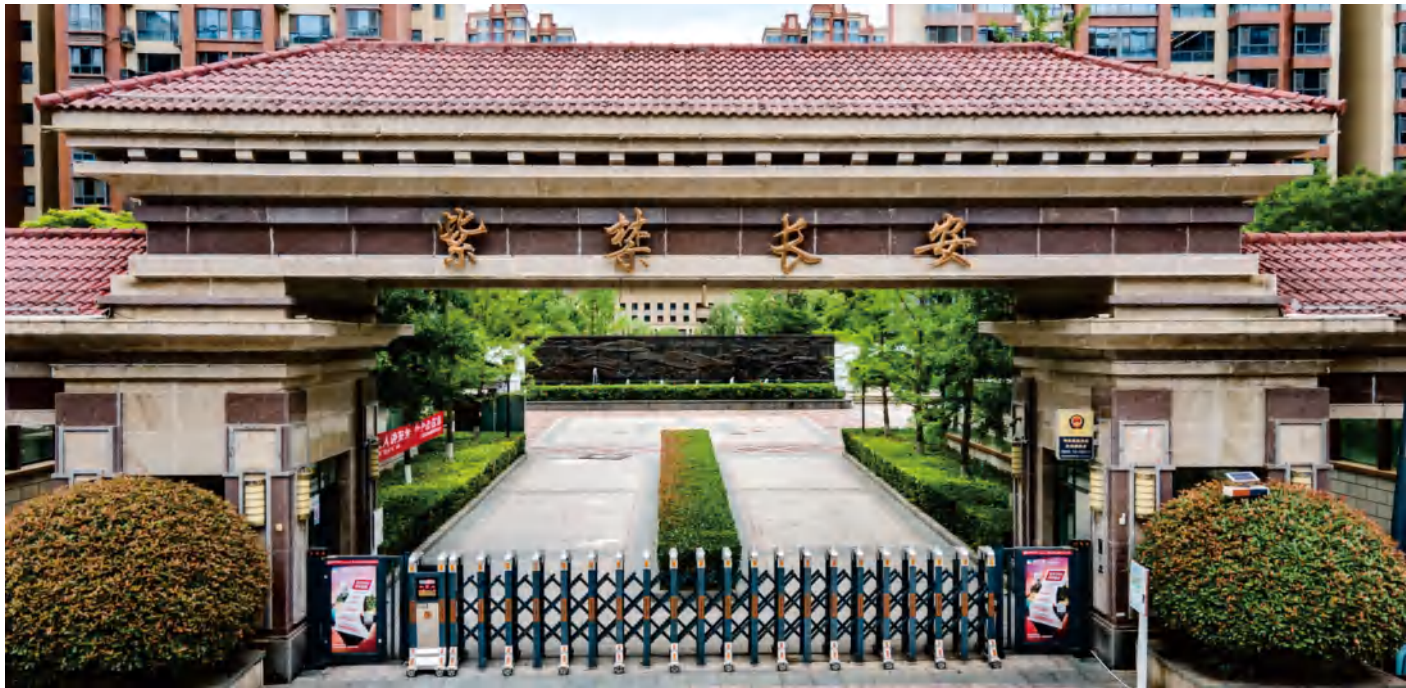
紫禁长安(一期)(IBO模式) 项目地址:西安国家民用航天产业基地 供热面积:30.66万㎡
