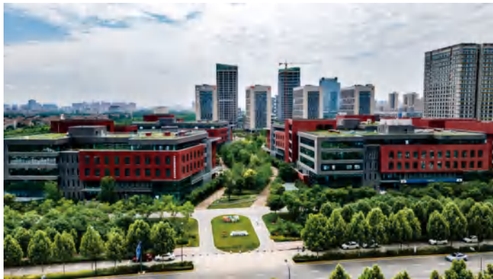
沣西新城总部经济园综合能源站(EC模式) 项目地址:西安 西咸新区 沣西新城 供热(冷)面积:69.00万㎡
