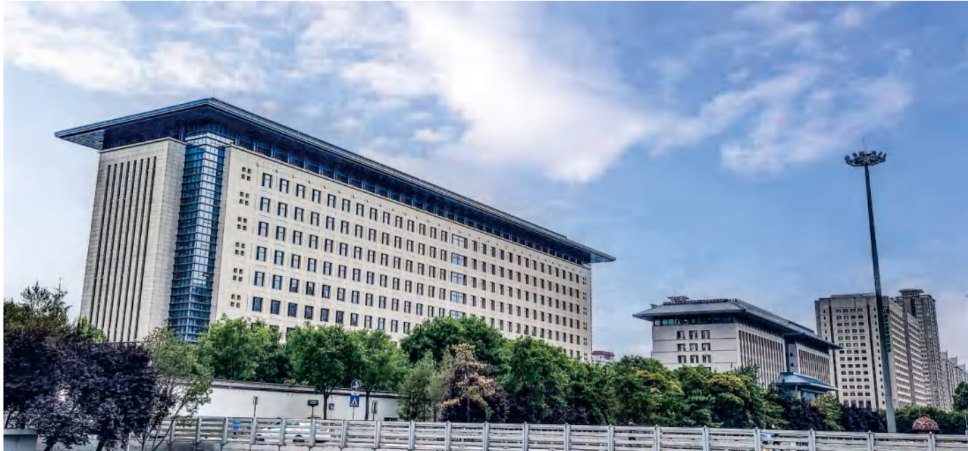
陕西省委办公楼(东、西大院)(EC模式) 项目地址:西安市雁塔区 供热(冷及生活热水)面积:13.46万㎡
