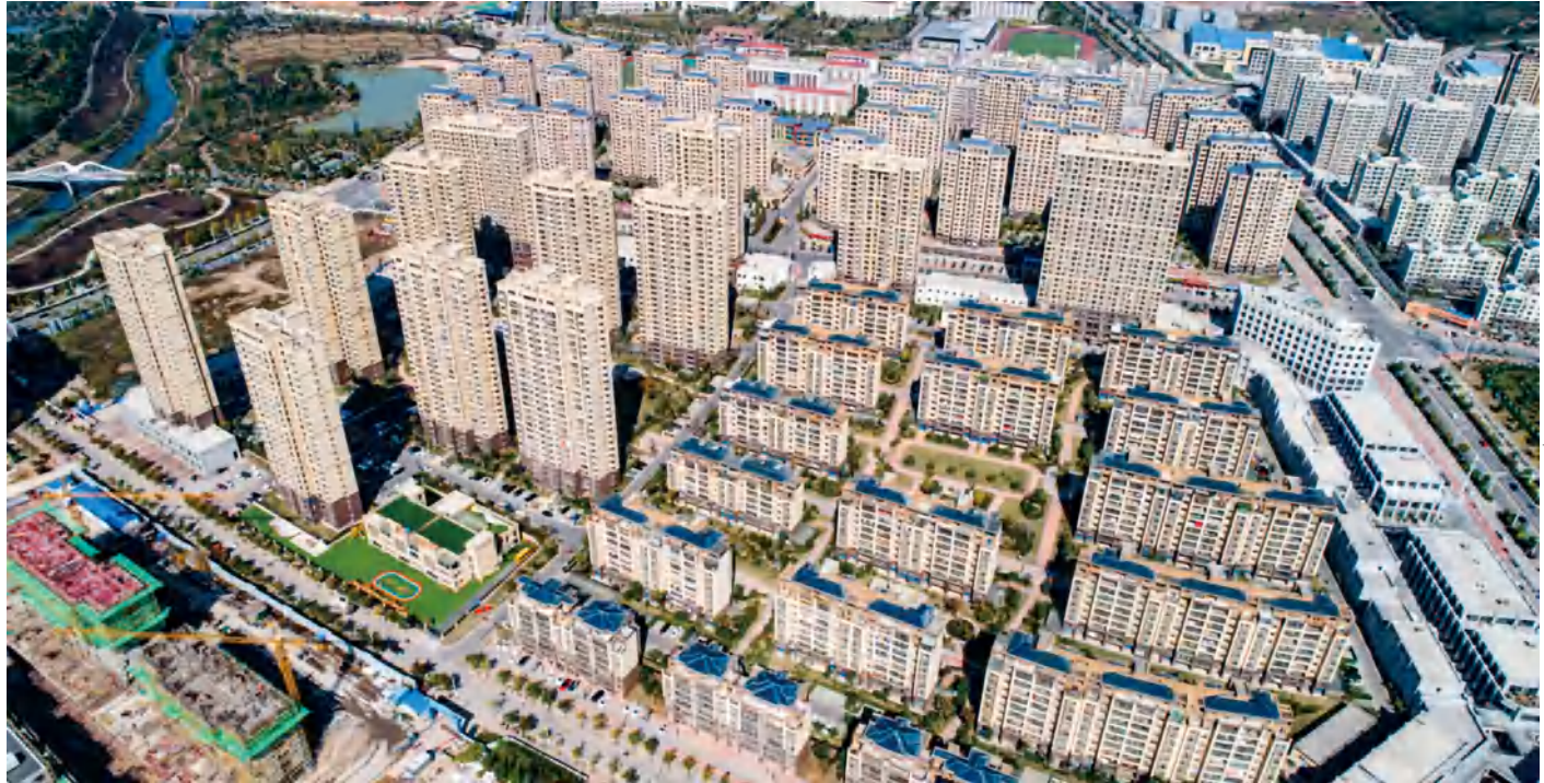
安徽正和一中公园小区(JIC模式) 项目地址:安徽省六安市金寨县 供热面积:9.50万㎡
