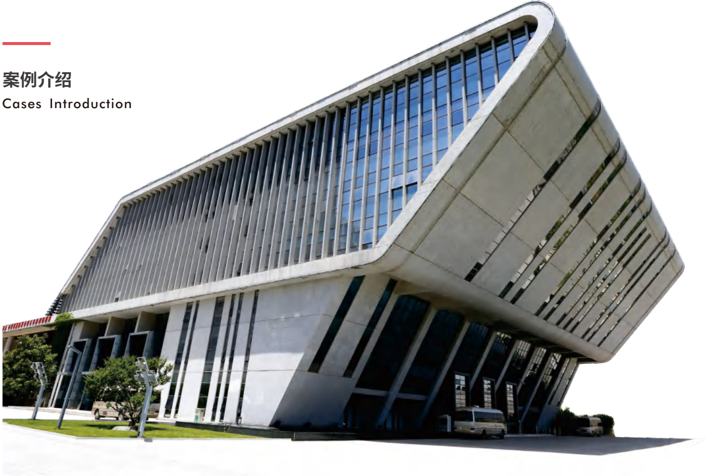
西安浐灞国际港管理委员会行政中心供热(冷)项目 (EC模式)
